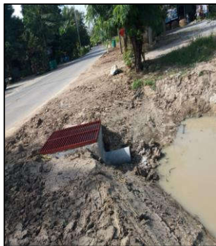
โครงการฝังท่อระบายน้ำพร้อมบ่อพักที่บ้านสระบัวเก่า หมู่ที่ 7 ระยะทาง 138 เมตร เป็นเงิน 369,000.- บาท เพื่อช่วยเหลือชุมชน ให้สามารถระบายน้ำออกสู่ภายนอกได้สะดวก ป้องกันน้ำท่วมขังในหมู่บ้านในฤดูฝน ตามโครงการ “ความร่วมมือเพื่อการพัฒนาชุมชน สังคม และสิ่งแวดล้อมอย่างยั่งยืน” ประจำปี 2561
